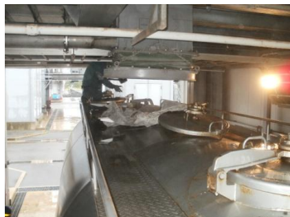
図-2 排出口改造後
